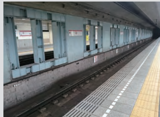
●地下鉄道トンネル
